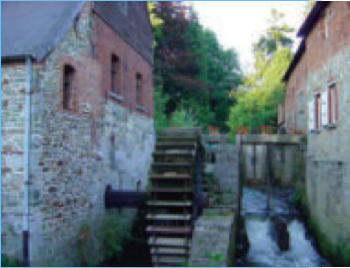
12.y.y Su Değirmeni (Belçika). Çark suyun gücüyle dönmektedir.
